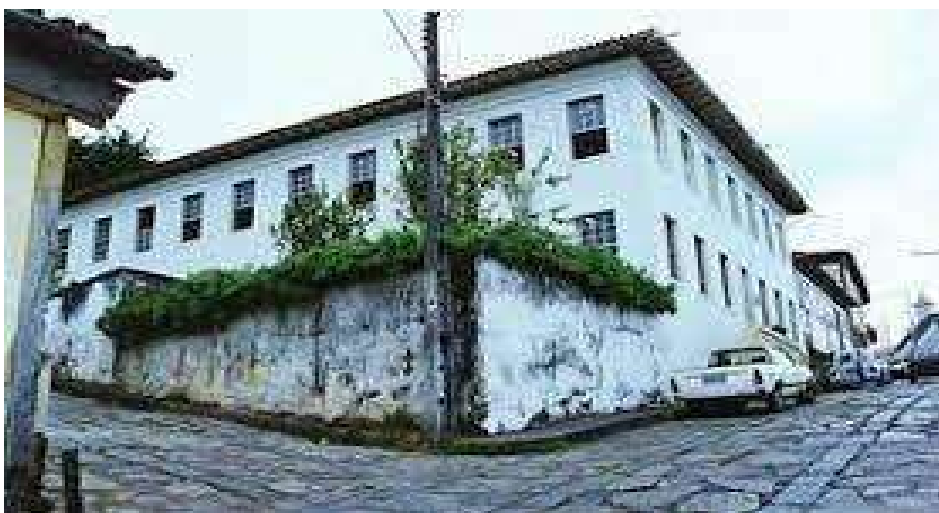
Figura 5: Conservatório Estadual Lobo de Mesquita, vista lateral Fonte: Facebook (Adriana Ribas)
